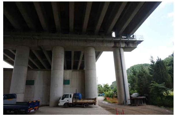
교각 P2 전경
