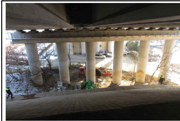
교각 P1 전경
